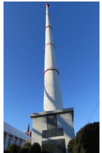
憶・原町無線塔
